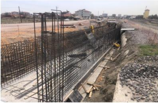
Afyon Gar menfez deplase işi, demir donatı çalışması devam etmektedir.
