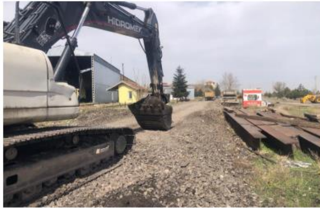
Afyon Gar tevsiyatı Faz-1, kazı-dolgu ve drenaj çalışması devam etmektedir.
