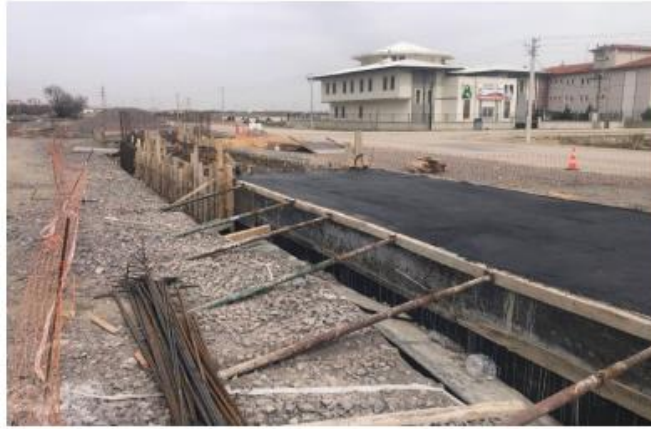
Afyon Gar menfez deplase işi, demir donatı çalışması devam etmektedir.
