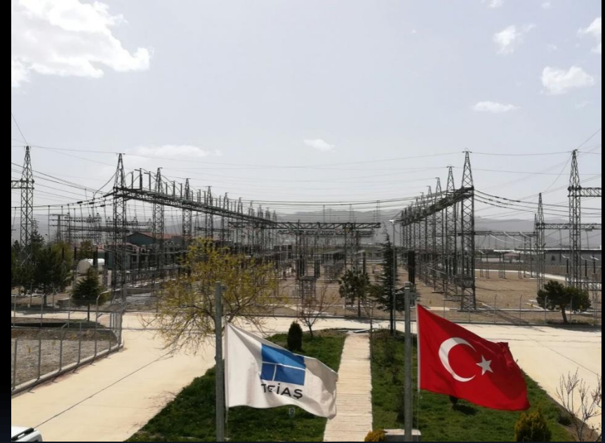
Afyon2 Trafo Merkezi
